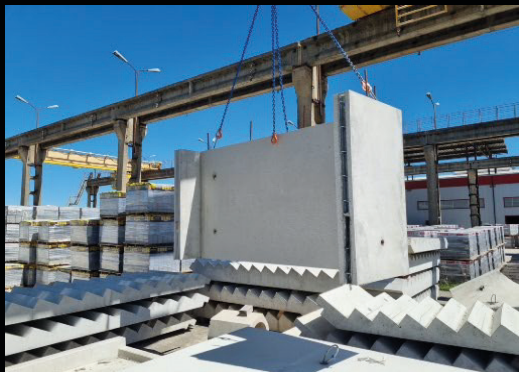
ściana szachtu windowego
