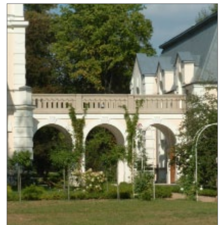
Odtworzenie balustrady – pałac w Suchej
