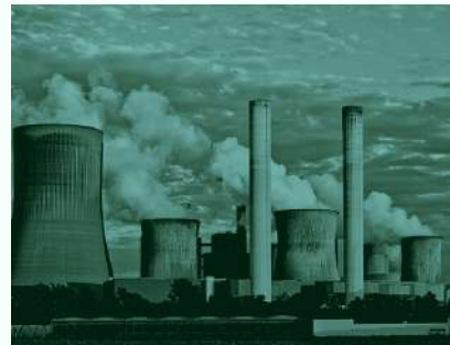
Zakłady przemysłowe (monitoring ścieków)
