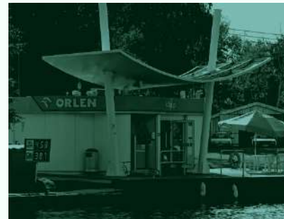
Wodne stacje paliw (wycieki substancji ropopochodnych)
