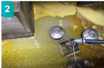
2 Z zasysanie mieszaniny wodno-olejowej przez ssak zamontowany w zbiorniku cieczy
