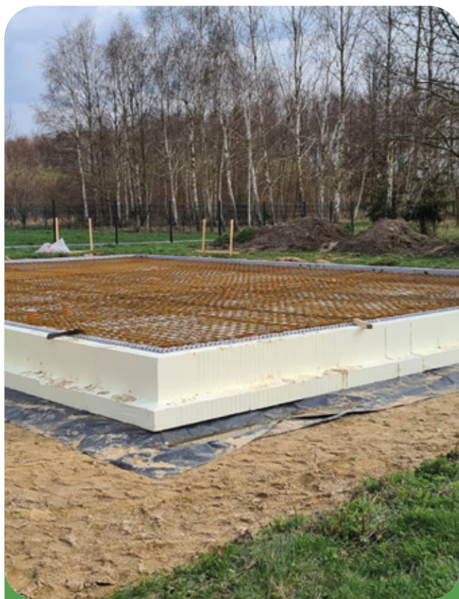
Układanie płyty fundamentowej IZODOM
