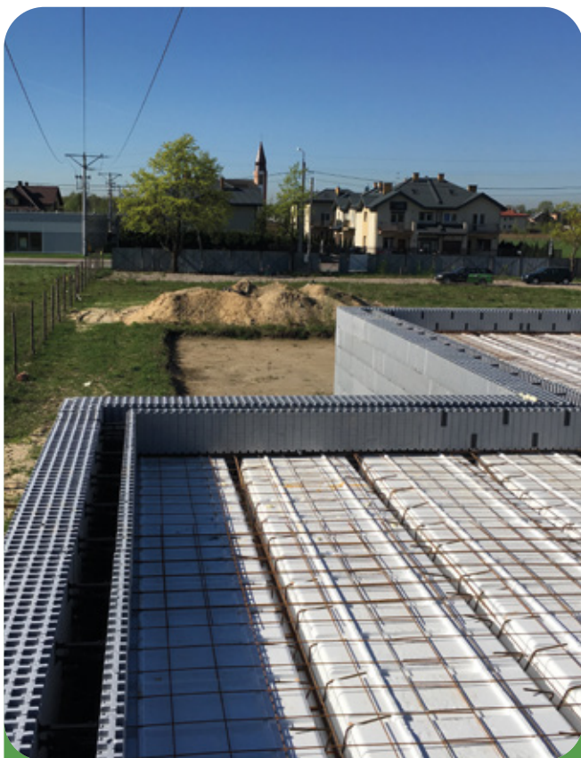
Układanie stropu IZODOM
