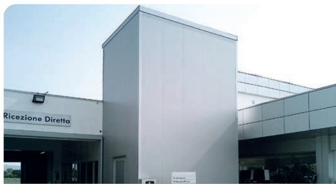
Instalacja regałów na zewnątrz budynków
