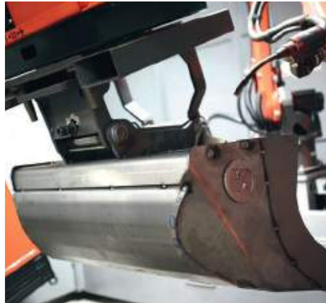
Przeprowadzono szeroko zakrojone prace rozwojowe nad systemami mocowań, aby osiągnąć możliwie najbardziej zautomatyzowany proces spawania.
