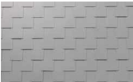
Krycie podwójne z zakładem bocznym
